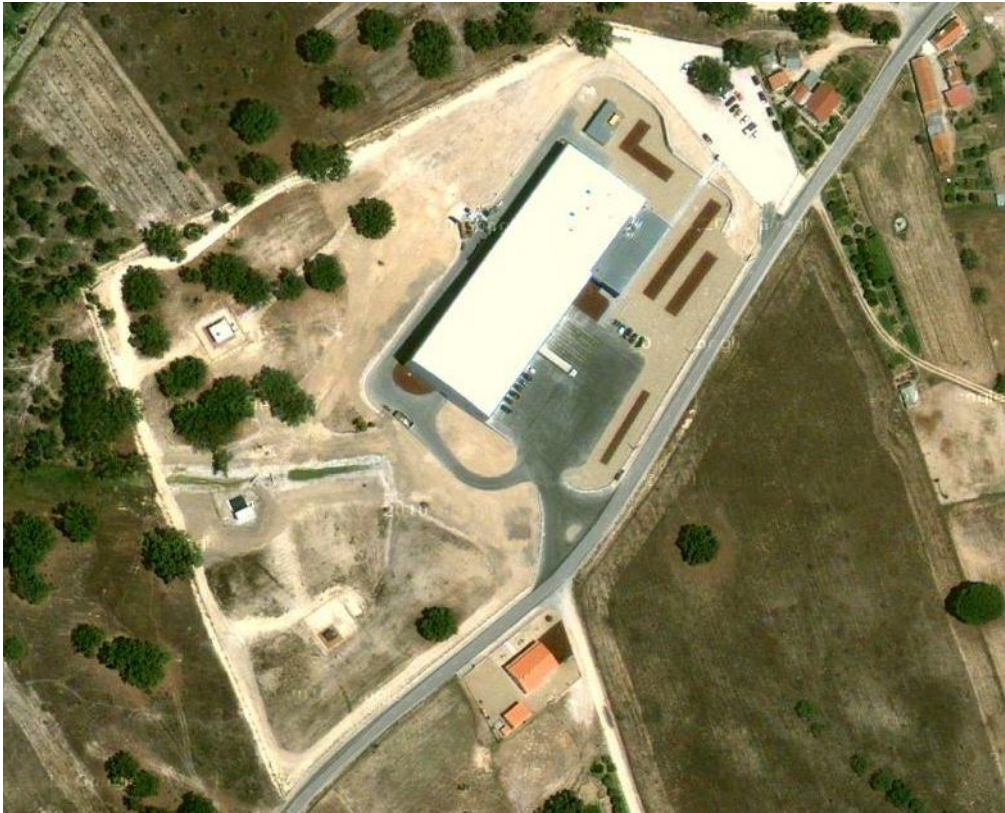
Figura 4 – Vista aérea da fábrica Nestlé Waters Direct Portugal
