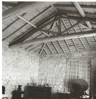
fig.36 | Arrifes - interior de casa levantada
