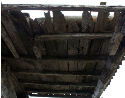
fig.21 | Estrutura cobertura alpendre
