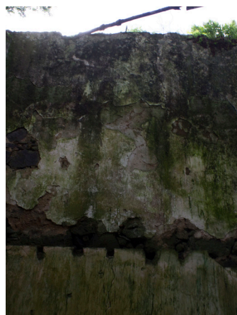
fig.34 | Marcação do piso
