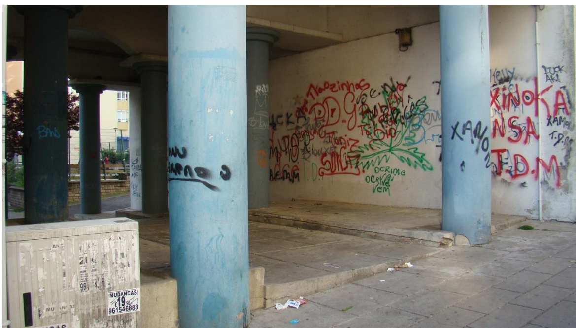
Fotografia 9: Galeria entre prédios com acesso ao campo de futebol.
