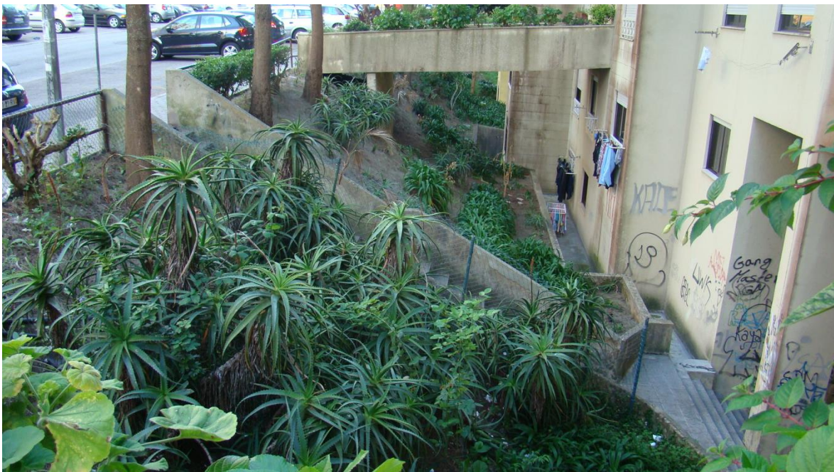
Fotografia 32: Espaços ajardinados em frente aos lotes, sem manutenção.
