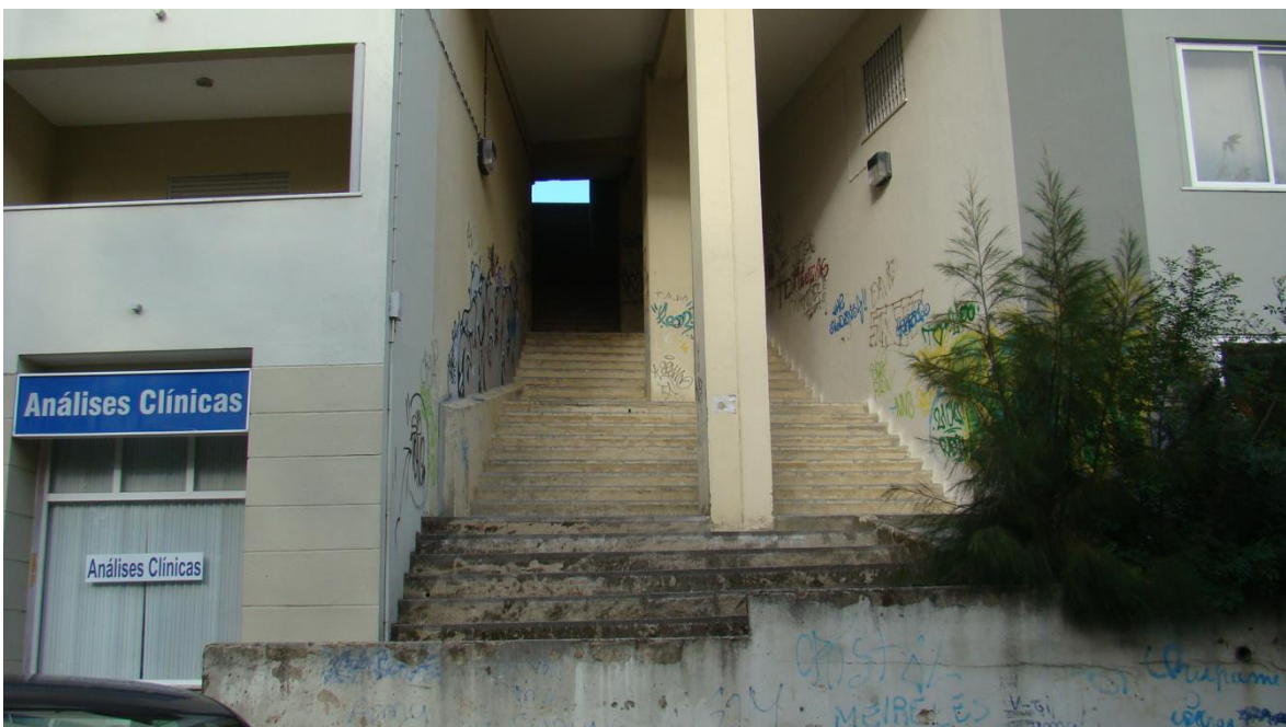
Fotografia 24: Escadas entre lotes com elevado declive.
