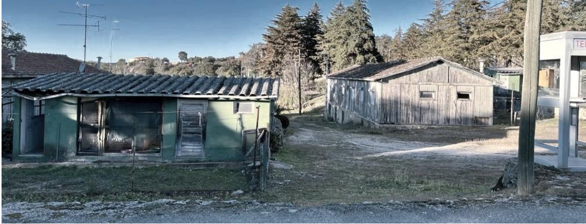
Figura 32 – Fotografia do processo (pré-existência)
