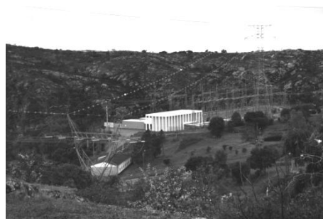
Imagem 07 - 6 Posto de transformação
