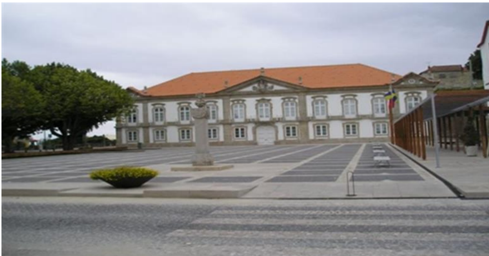
Figura 1 - Edifício Paços do Concelho
