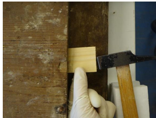
Fig. 104. Levantamento da tábua exercendo pressão recorrendo a cunhas e martelos. (A.P.)
