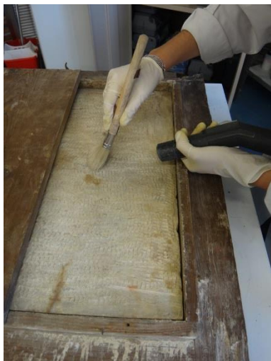
Fig. 113. Limpeza com trincha com aspiração, em simultâneo. (A.P.)
