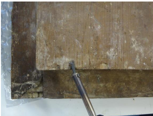
Fig. 103. Dilatação de pregos com ponta metálica eléctrica. (A.P.)
