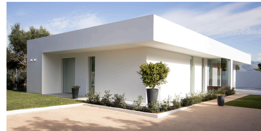
Fig. 151. Entrada, Casa Fiorito. Foto fornecida pelo estúdio.
