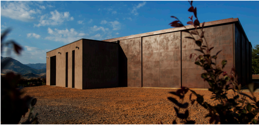
Fig. 143. Exterior: Cantina Alta Mora. Foto fornecida pelo estúdio.
