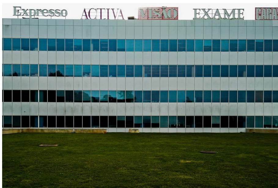
Figura50 Edifício da delegação Norte do Grupo Impresa em Matosinhos (Local onde decorreu o estágio)
