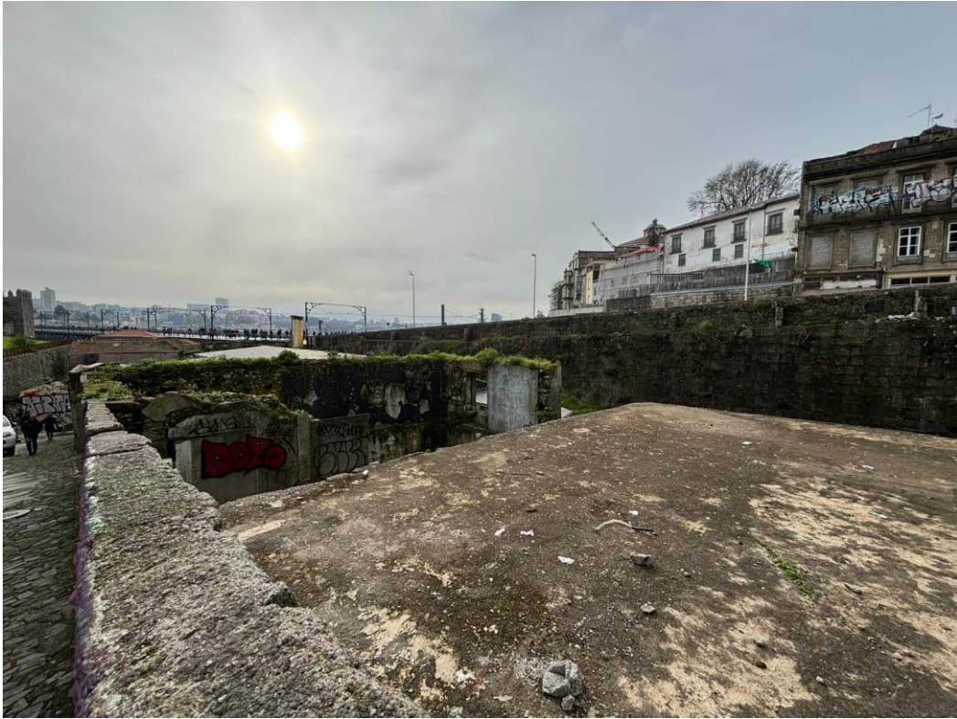
Figura 20: Foto do terreno 02.
