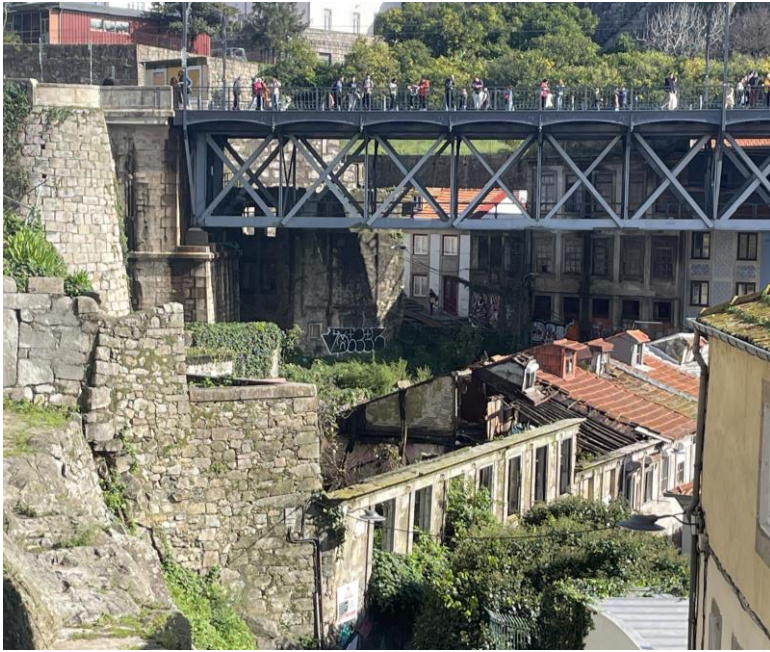
Figura 24: Foto do terreno 06.
