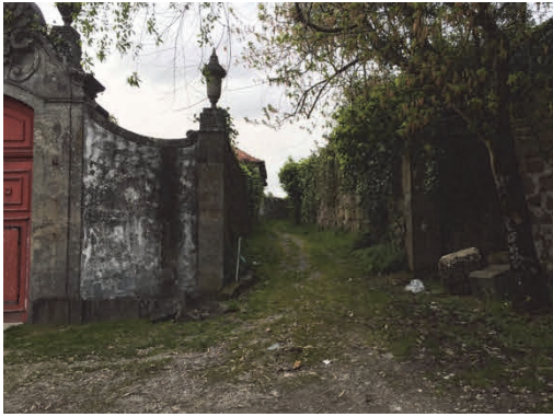
Figura 60 – Muros junto à entrada da Quinta da Revolta
