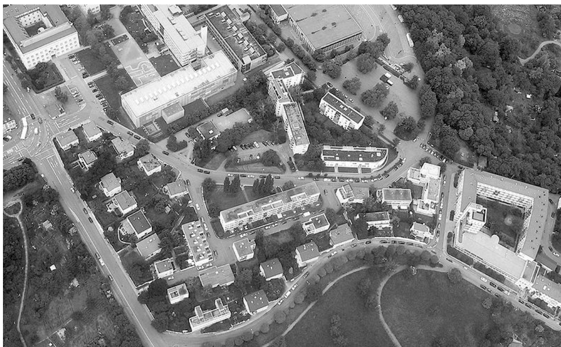
Fotografia 588 | Weissenhofsiedlung, Estugarda, Alemanha (2004 - fotografia aérea)
