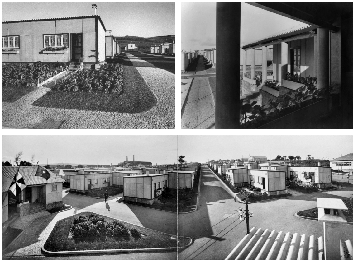
Fotografia 836 | 1ª fase de construção, casas de fibrocimento e madeira, bairro da Boavista (1940) Fonte: Arquivo Fotográfico de Lisboa
