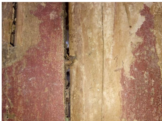
Figura 29 Pormenor da retração da madeira, no verso da folha 2, deixando uma cavilha à mostra
