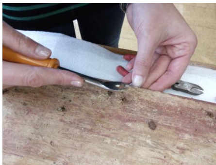
Figura 57 Pormenor da remoção dos pregos do verso
