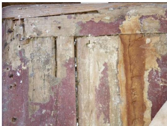
Figura 32 Pormenor de preenchimentos com madeira e com massas, já envelhecidas
