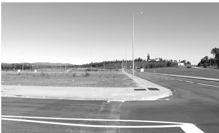
Fig. 35 - Zona Industrial 2 (arruamentos)
