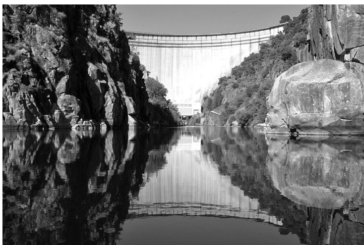
Fig. 31 - Barragem do Cabril
