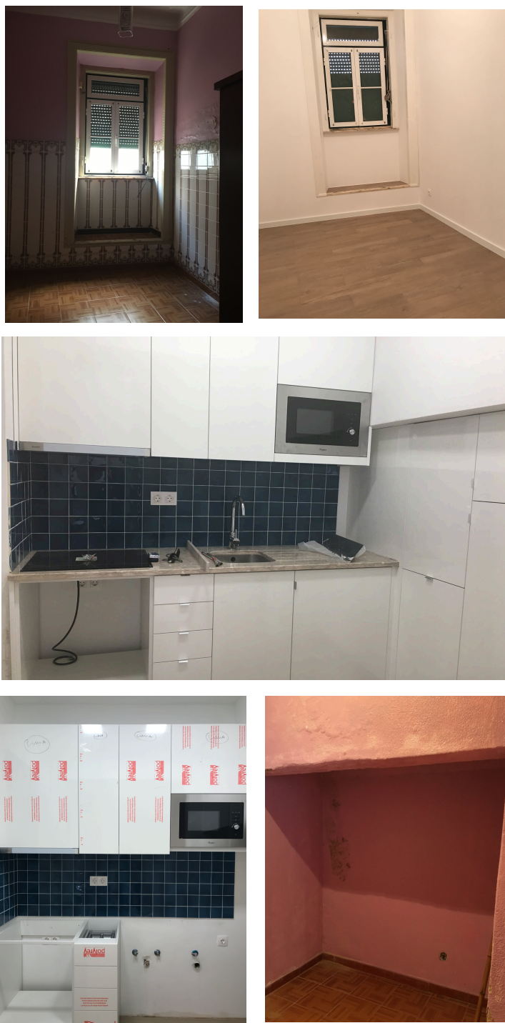
Figura 31 | Acompanhamento de obra em Lisboa.
