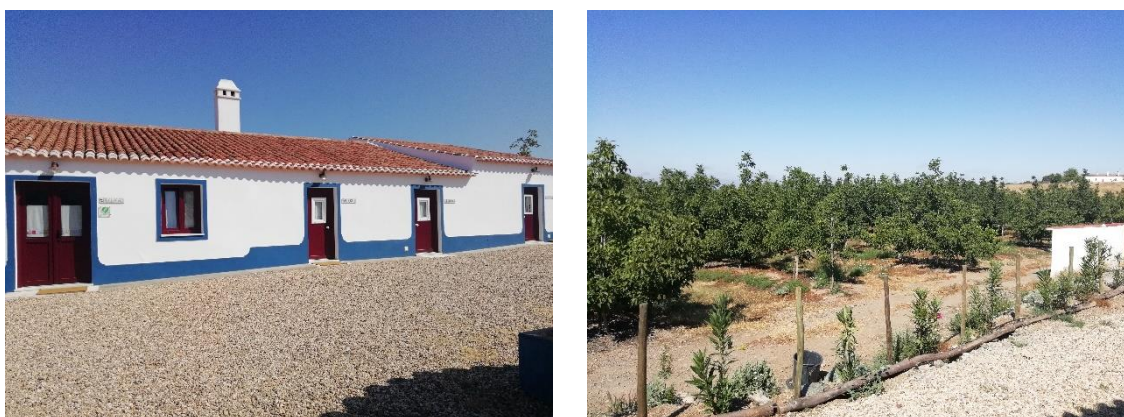
Figura 49 – Edifício do Monte Pantaleão, entradas da receção, apartamentos (à esq.) e área de cultivo (à dir.)
