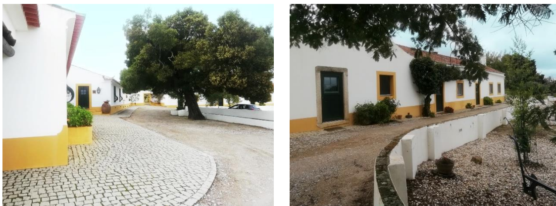
Figura 41 – Zona exterior (à esq.) e fachada de um edifício da Quinta da Espada (à dir.)
