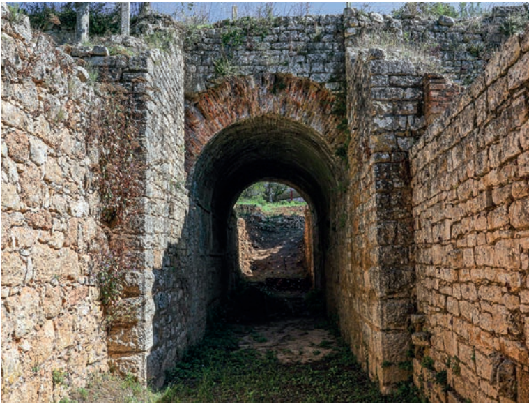
Fig. 5 O viaduto, estrutura que pode ter funcionado como aditus maximus do teatro. © Arlindo Homem.
