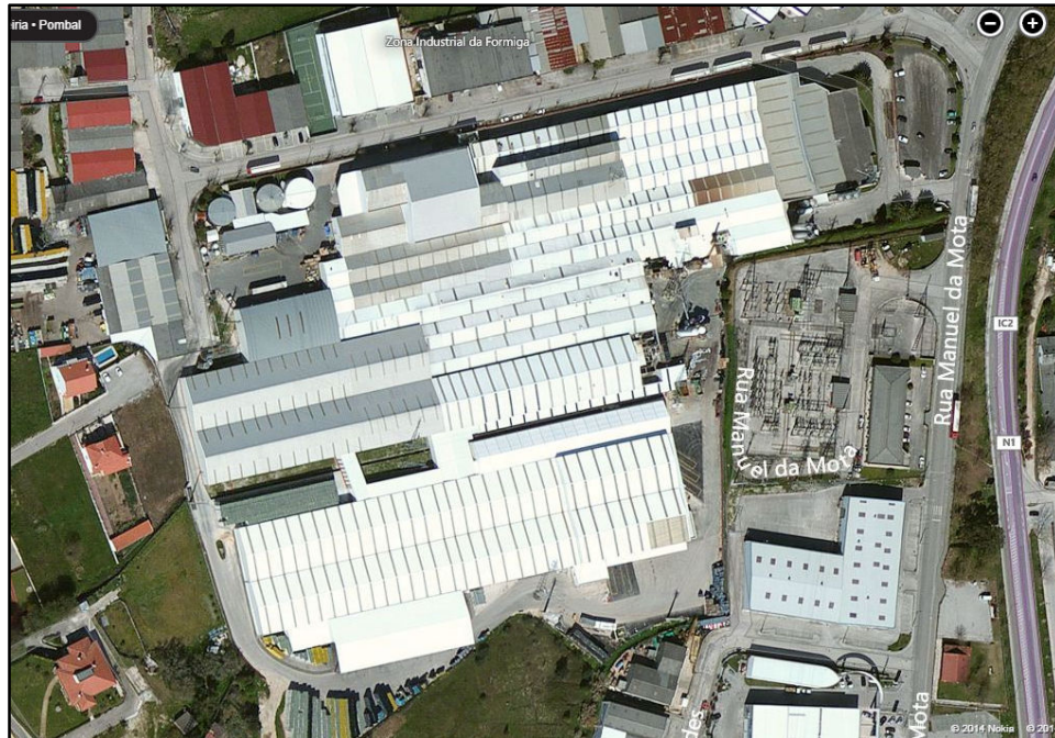
Figura 2.4 - Vista aérea fábrica Pombal
