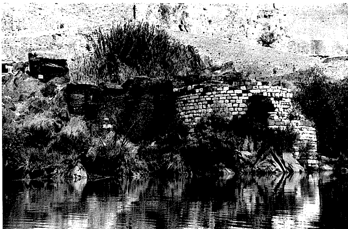
Fot. 3 Vista geral da torre do rio a nascente
