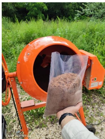
Figura 23 - Betoneira utilizada para preparação dos substratos
