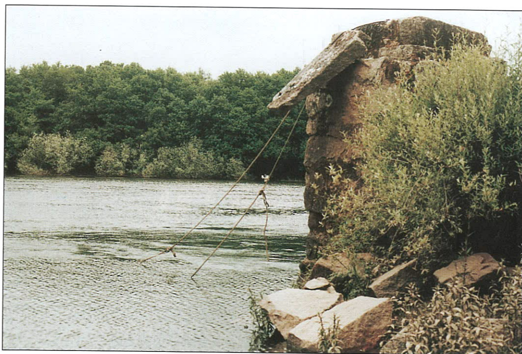
Fotografia 9 - Torre da Lapela - Cabos de amarração da cabaceira à pesqueira.
