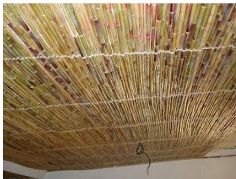
Figura 51 – Teto de habitação com caniço
