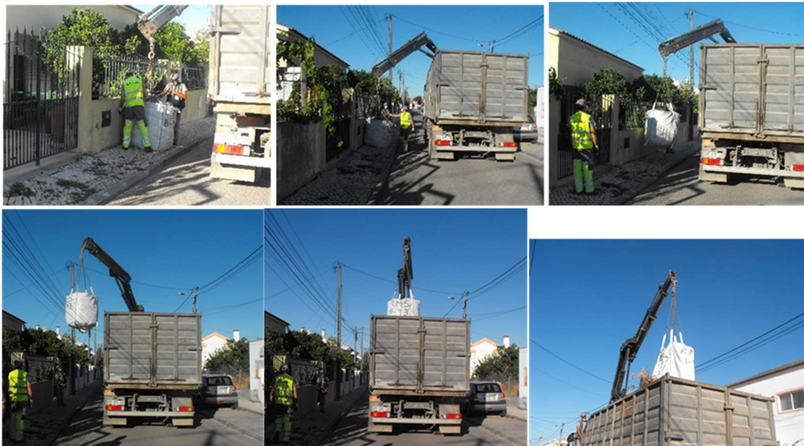
Figura 12 - Tarefas realizadas pelos assistentes operacionais no decorrer da atividade de recolha de RCD
