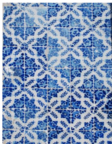
Figura 108 Preenchimento com reutilização de azulejos
