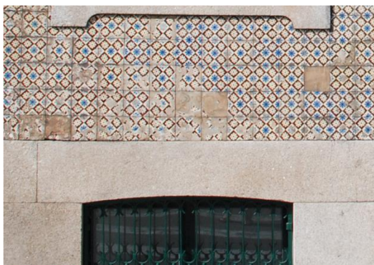
Figura 84 Infiltrações ascendentes 116
