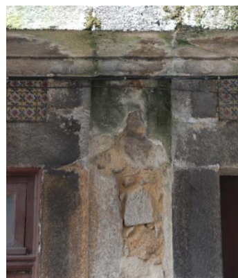
Figura 85 Infiltrações descendentes 117
