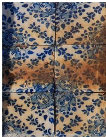
Figura 98 Depósitos de óxidos de ferro 129
