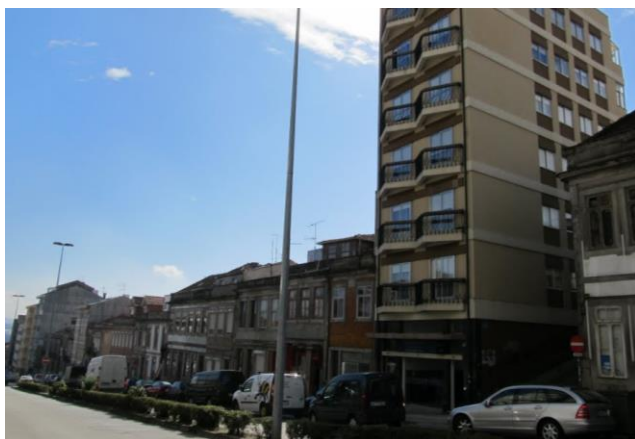
Figura 116 Edifícios em banda, intercalados com prédios modernos
