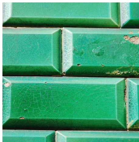
Figura 93 Defeitos de fabrico 124
