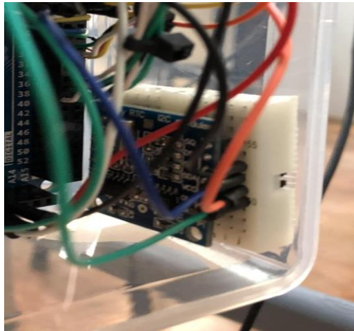
Figura 38 – Shield RTC instalado.
