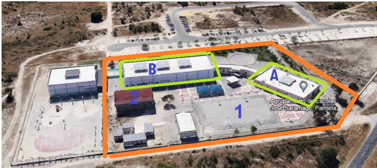
Figura 2 - Escola José Saramago com as respetivas zonas assinaladas (retirado do Google Maps)
