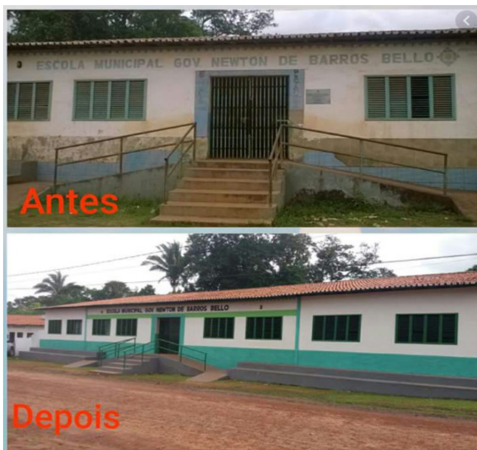
Figura 3. – Vista principal da Escola Municipal Governador Newton de Barros Bell, após sua reforma
