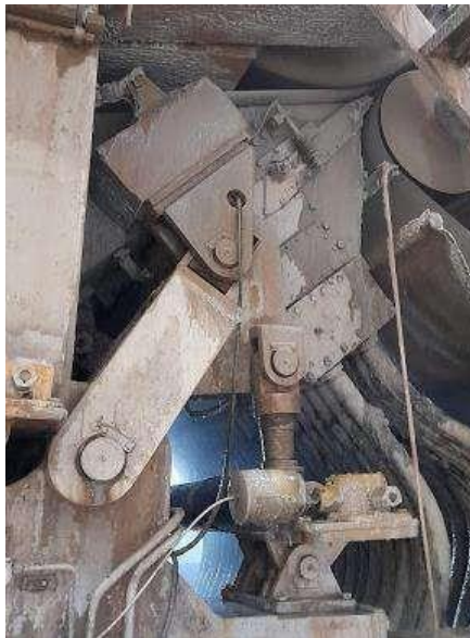
Figura 61 - Caixa de Chegada - CX1
