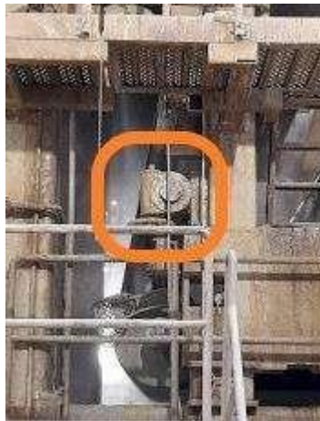
Figura 23 - Caixa de Vácuo entre Rolo nº15 e 16 da MP6
