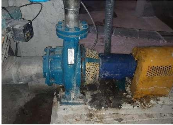
Figura 59 - Bomba do tinão de pasta reciclada - BB601
