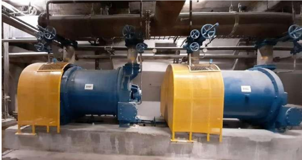
Figura 34 - Bombas de vácuo
