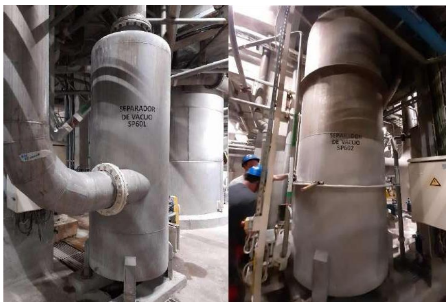
Figura 33 - Separadores de vácuuo
