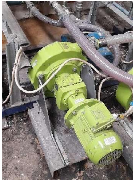
Figura 63 - Bomba doseadora de Magnafloc - BQ104
