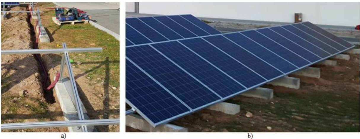
Figura B.5 – a) Vala para ligação das diversas strings e tubo PEAD de 50 mm, b) Módulos colocados sobre estrutura triangular e sobre lancis.
