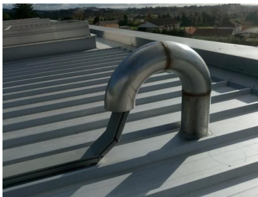
Figura 5.24 - Caminho de cabos dos telhados superiores.
