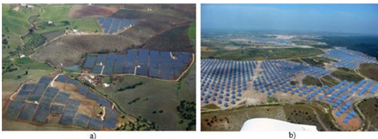
Figura 3.3 – a) Central Solar fotovoltaica de Serpa (PFS, 2007), b) Central Solar fotovoltaica de Amareleja (GeoMentor, 2013).
