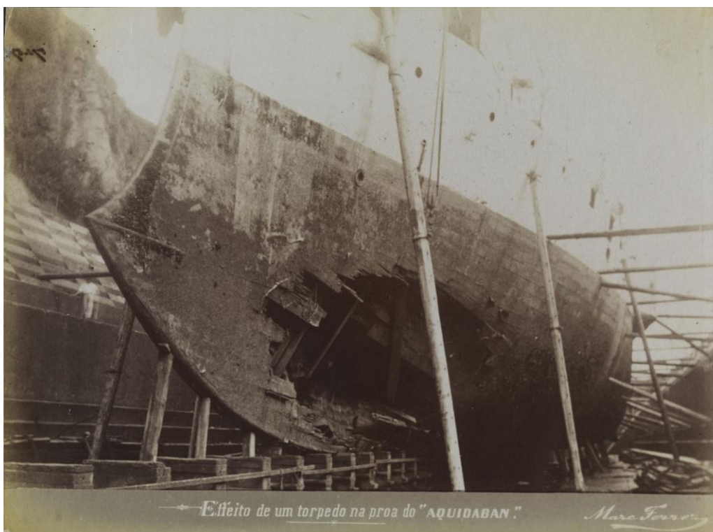
Figura 4 - Danos causados por um torpedo ao navio brasileiro Aquidabá. Fonte: Acervo – Fundação Biblioteca Nacional. Adaptado de A Revolta da Armada / Brasiliana Fotográfica (bn.gov.br) (Consultado em 04 de março de 2022.)
