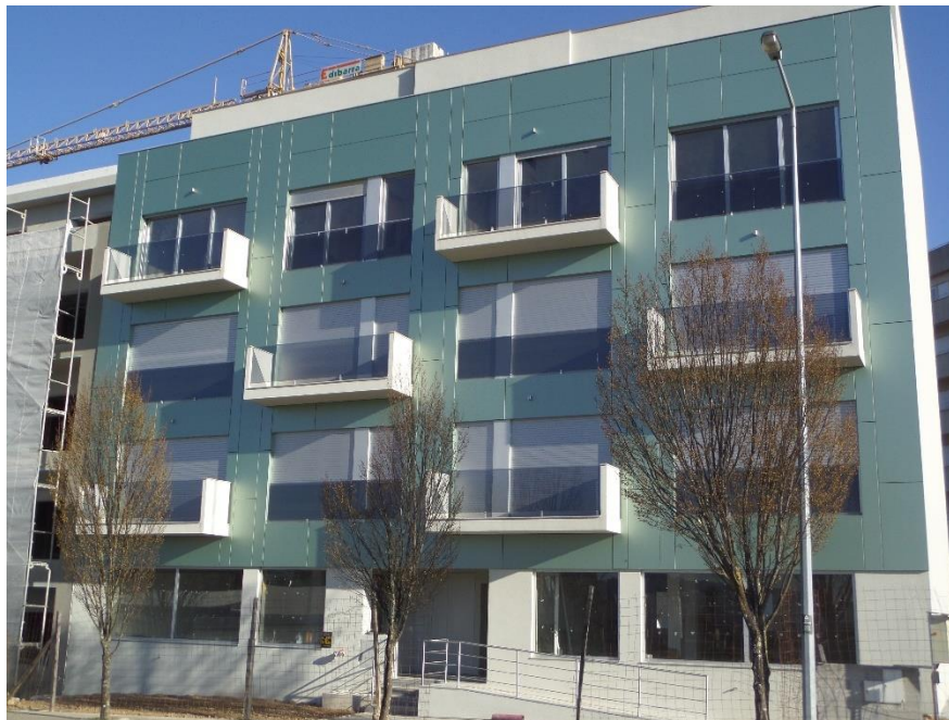
Figura 28 - Fachada principal do edifício.
