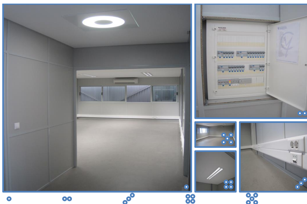
Figura 6 – Imagens elucidativas da intervenção realizada na Base Aérea de Ota.
