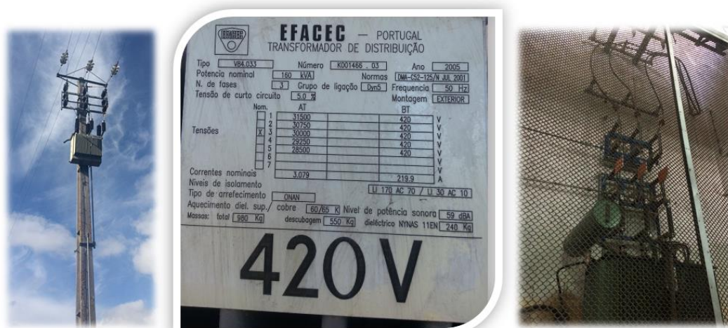
Figura 11 - Imagens elucidativas da intervenção realizada nos Postos de Transformação pertencentes à empresa das Águas de Santarém.
