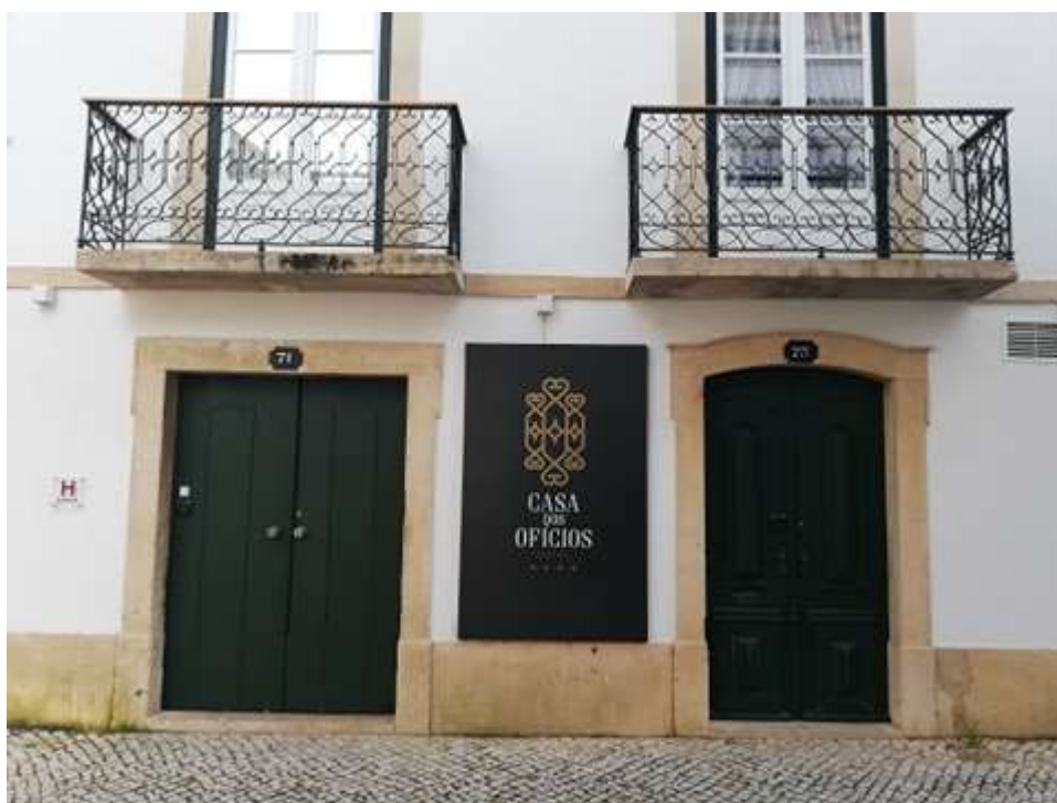
Figura 7 - Fachada da Casa dos Ofícios Hotel.
