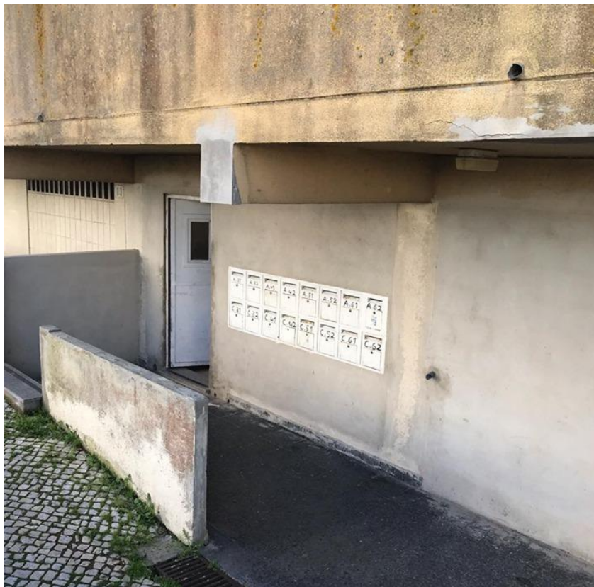
Imagem 73 | Colocação de portões por parte da CMS/habitantes
