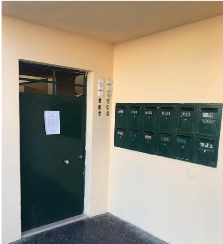
Imagem 54 | Colocação de portões por parte da CMS/habitantes
