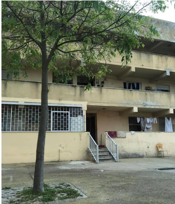
Imagem 64 | Estrutura do edificado do Bairro da Bela Vista
