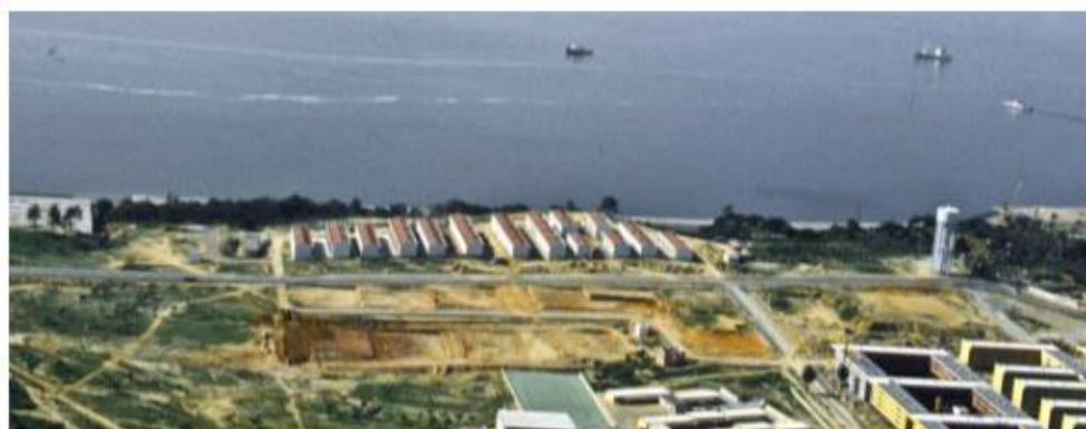
Imagens 49, 50 e 51 | Início da construção do Bairro da Bela Vista Fonte: Cabral (2015)
