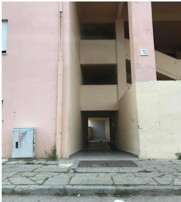
Imagem 65 | Estrutura do edificado do Bairro da Bela Vista
