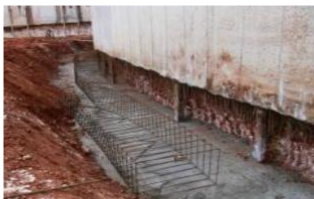
Figura 2.12 - Armadura da sapata (Santos, João, 2011)
