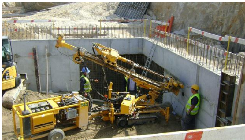
Figura 2.8 - Máquina de furação para abertura do furo da ancoragem (Georumo, 9/10/2013)
