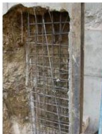
Figura 2.6 - Pormenor da armadura de espera (Santos, João, 2011)
