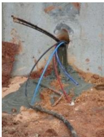
Figura 2.10 - Injeção primária concluída (Oliveira, Inês, 2012).
