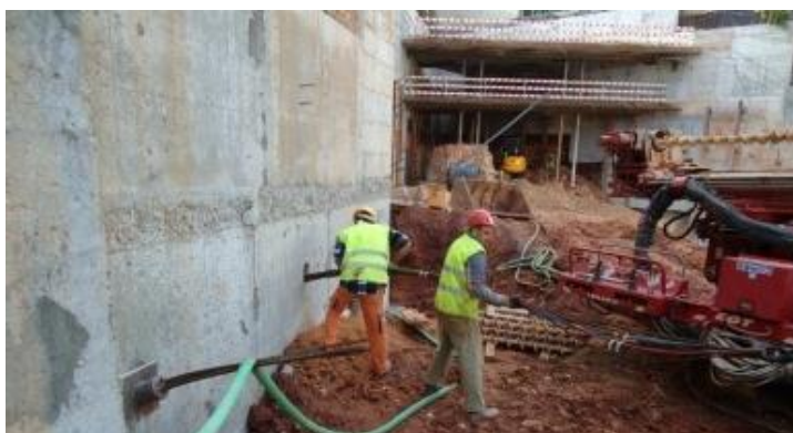
Figura 2.9 - Colocação dos cabos de ancoragem e bainhas de injeção (Oliveira, Inês, 2012)
