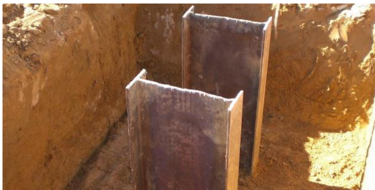
Figura 2.1 - Perfis metálicos cravados no terreno (Tecgeo, 09/10/2013)
