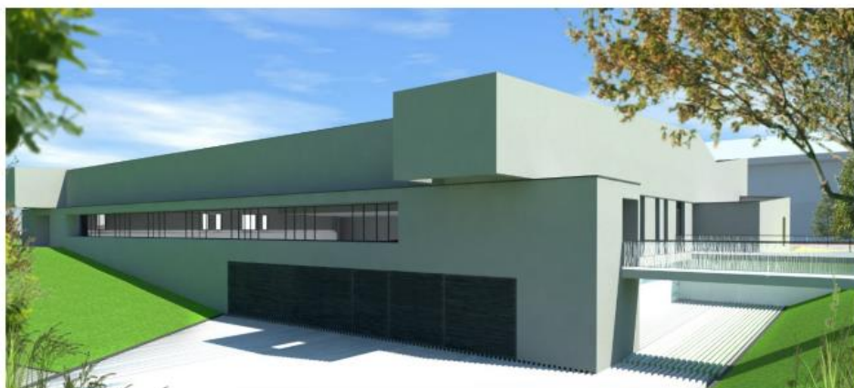
Figura 18 - Acesso direto do exterior - central Térmica. Fonte: Projeto de arquitetura.
