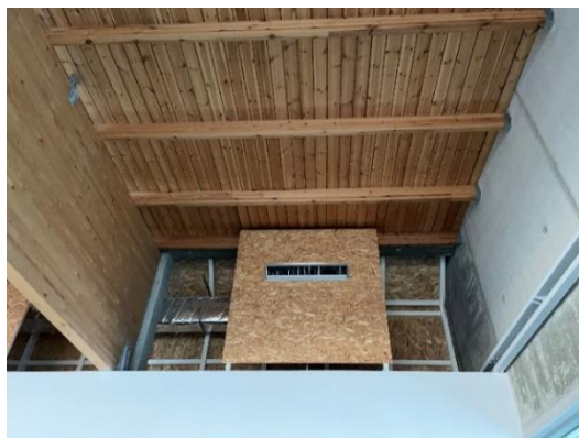
Figura 22 – Desumidificador. Fonte: Autor.
