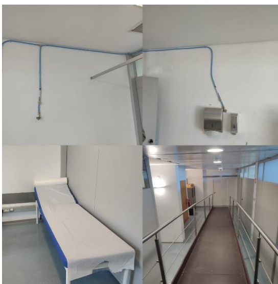
Figura n.º 7 - Instalação de rampas, condutas de oxigenação e camas para doentes COVID-19 -
