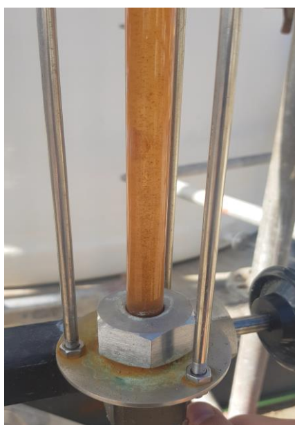
Figura 35: Nível do 806-G antes do purgado.
