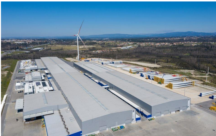
Figura 13 - Instalações fabris da Siemens Gamesa em Vagos
