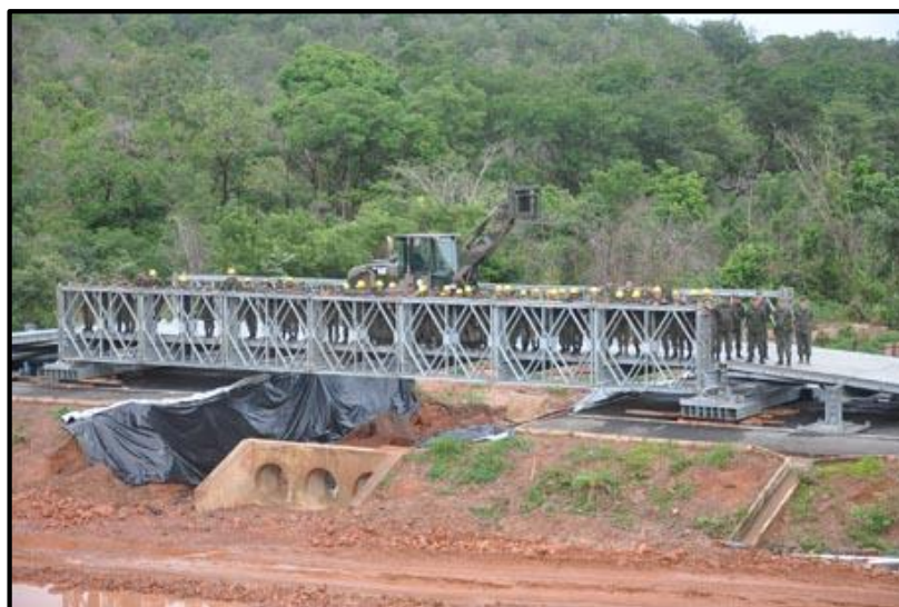
Figura n.º 21 - Ponte LSB
