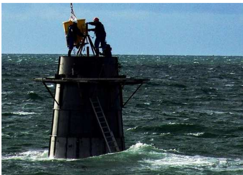
Figura 2.5 – Reforço estrutural com UHPC da torre marítima de Cabon, França [8];
