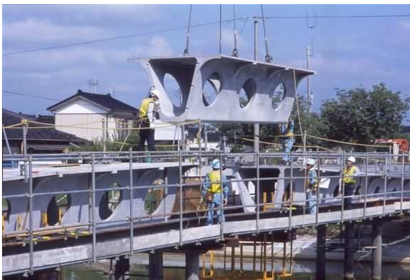
Figura 2.2 – Construção do Tabuleiro da ponte Sakata Miari no Japão [7];
