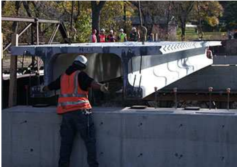
Figura 2.3 – Construção da ponte Washington, Estados Unidos [6];
