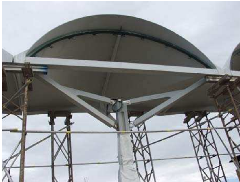
Figura 2.7 – Palas da estação de Shawnessy, Canadá, em fase de construção [9];
