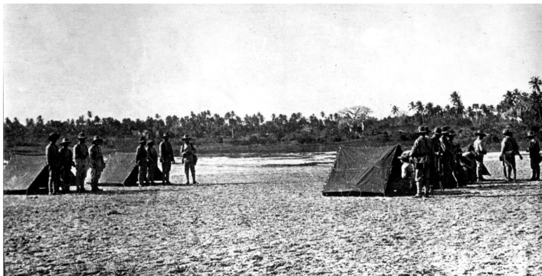
Fig. 9- Tendas de abrigo 16
