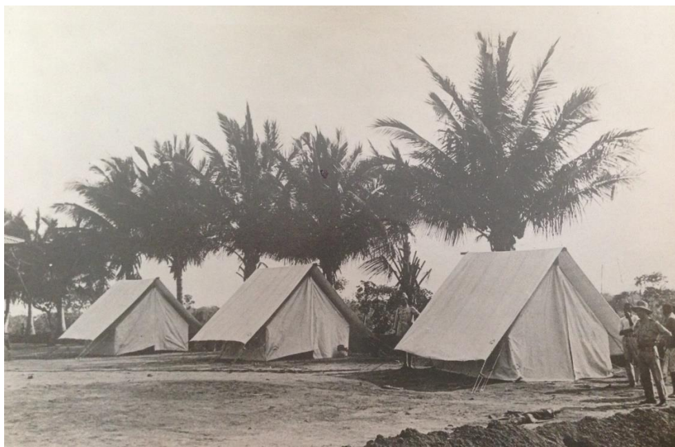
Fig. 18- Tendas de campanha onde se alojaram os oficiais 25
