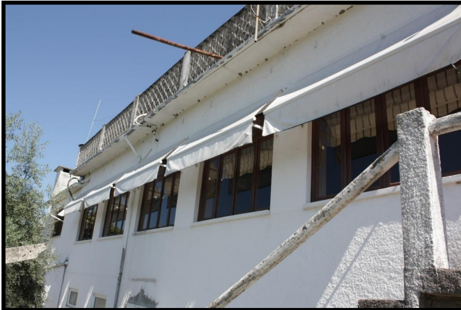
Figura IV.3 - Fachada sudoeste (janelas).
