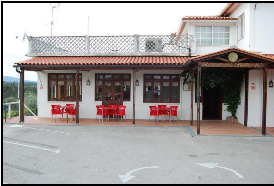
Figura IV.2 - Fachada sudeste (entrada).
