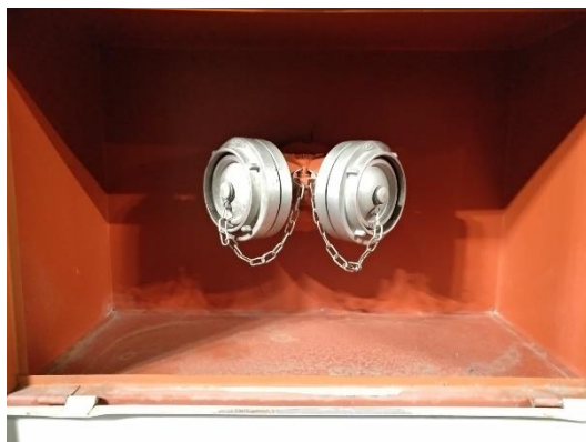
Figura 5: Exemplo de boca siamesa de alimentação e respetiva sinalética
