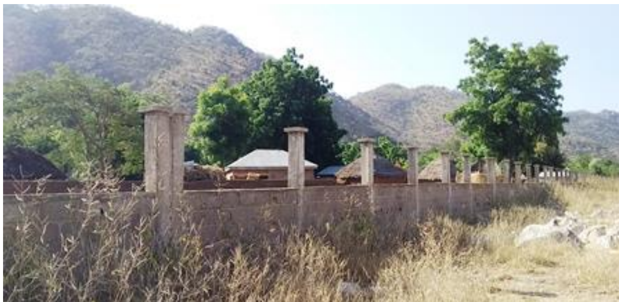
Figure 29: Nouvelle barrière en parpaings 2008@ KAJI 2021
