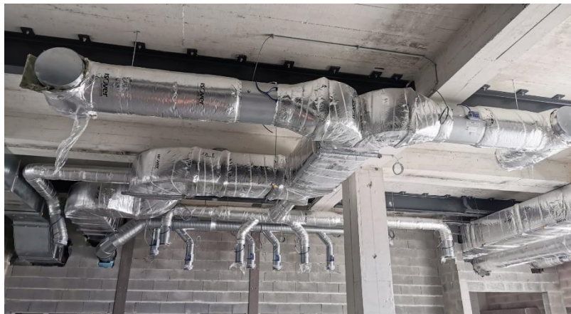
Figura 41 – Condutas metálicas
