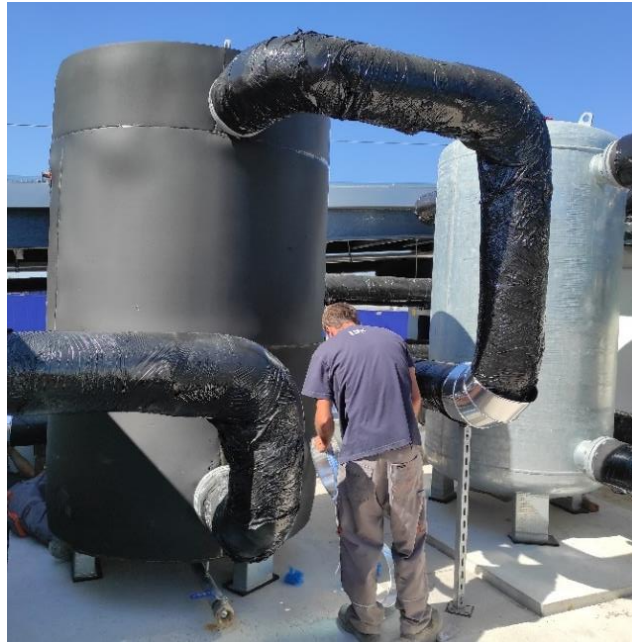
Figura 45 – Depósitos de inércia
