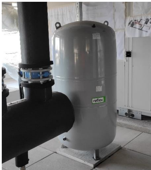
Figura 46 – Vaso de expansão
