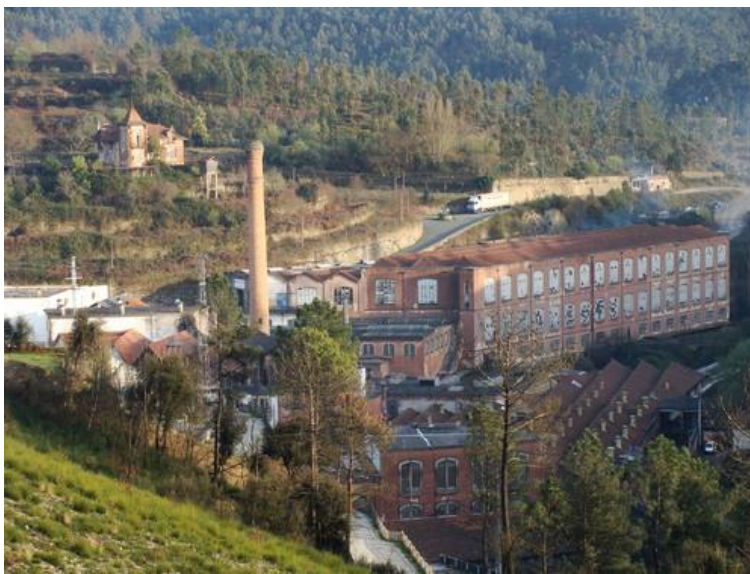
Ilustração 33 – vista da Companhia de Fiação de Crestuma
