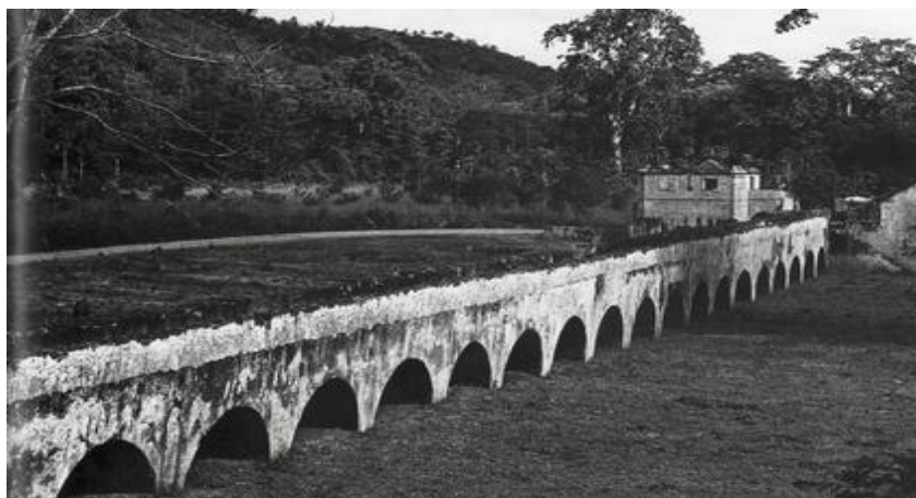
Ilustração 1 - Aqueduto e torre de fundição de Nova Oeiras, anos 1960
