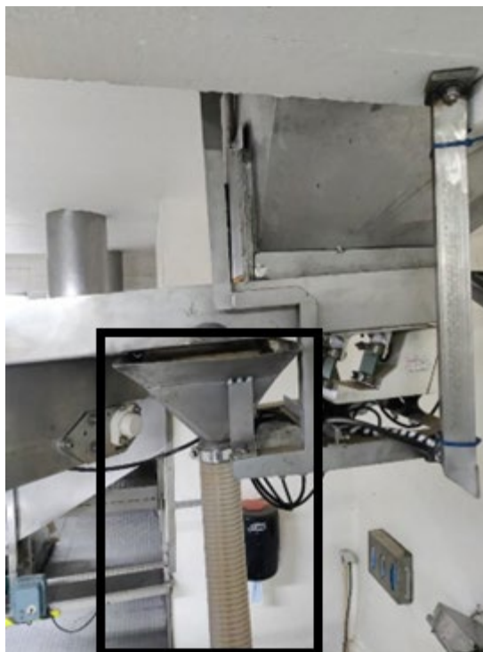
Figura 4.5 – Silo da Máquina 4
