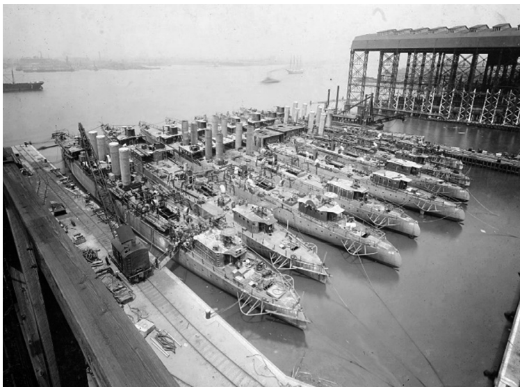
Figura 15 – Esta imagem de oito contratorpedeiros da classe Wickes, geralmente conhecidos como “the flush decker type”, em construção na New York Shipbuilding Corporation, Camden, New Jersey em 1919 ilustra a natureza de “a quantidade é uma qualidade em si própria” do programa de contratorpedeiros Norte-Americano da Primeira Guerra Mundial. Não sendo um desenho excepcional, a sua disponibilidade em grandes números para conversão em escoltadores oceânicos viria a fazer deles uma arma vital na Batalha do Atlântico na Segunda Guerra Mundial
