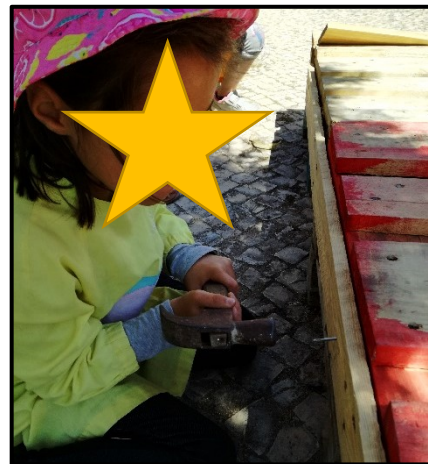
Legenda: Continuação da construção do Palco. Fonte: Autoria própria.
