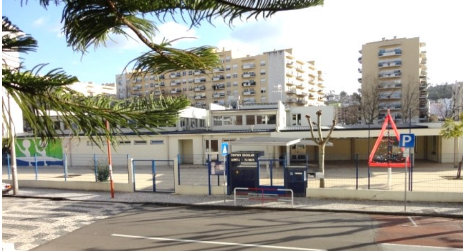
Figura 10 - Vista parcial da Escola.
