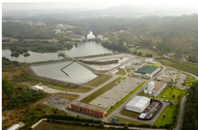
Figura 5 - Estação de Tratamento de Água de Areias de Vilar (Imagem retirada do site Águas do Norte)
