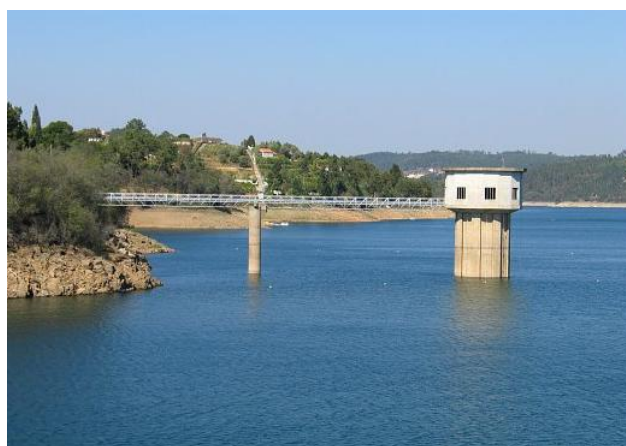
Figura 4 - Sistema de captação de água superficial na barragem de Castelo do Bode (Imagem retirada do site ESTRUTOVIA)
